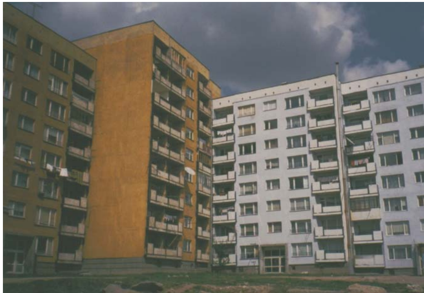
Изглед от неремонтирани и ремонтирани блокове
