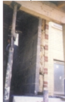
Изолация между двата елемента на външните стени на сградата в Бристол
