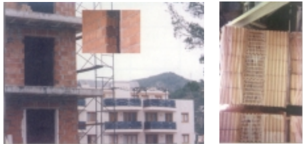
Тухли с ниска топлопроводимост, използвани за сградите в Барселона
